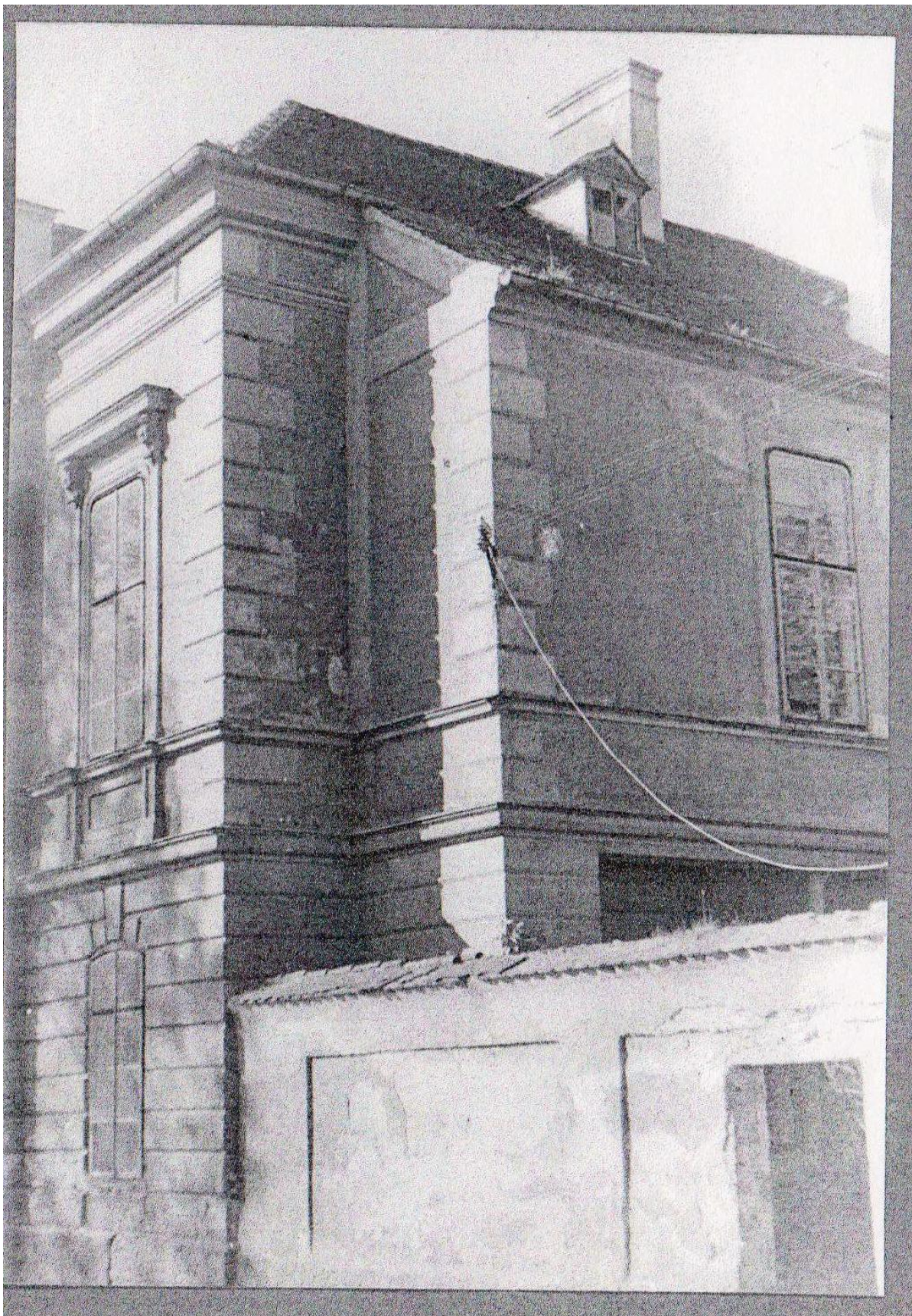
Nároží s detailem kordonové římsy s oplechováním. Architráv kordonové římsy na severní straně domu je bez profilace. Okno ve 2.NP je zadrženo.
