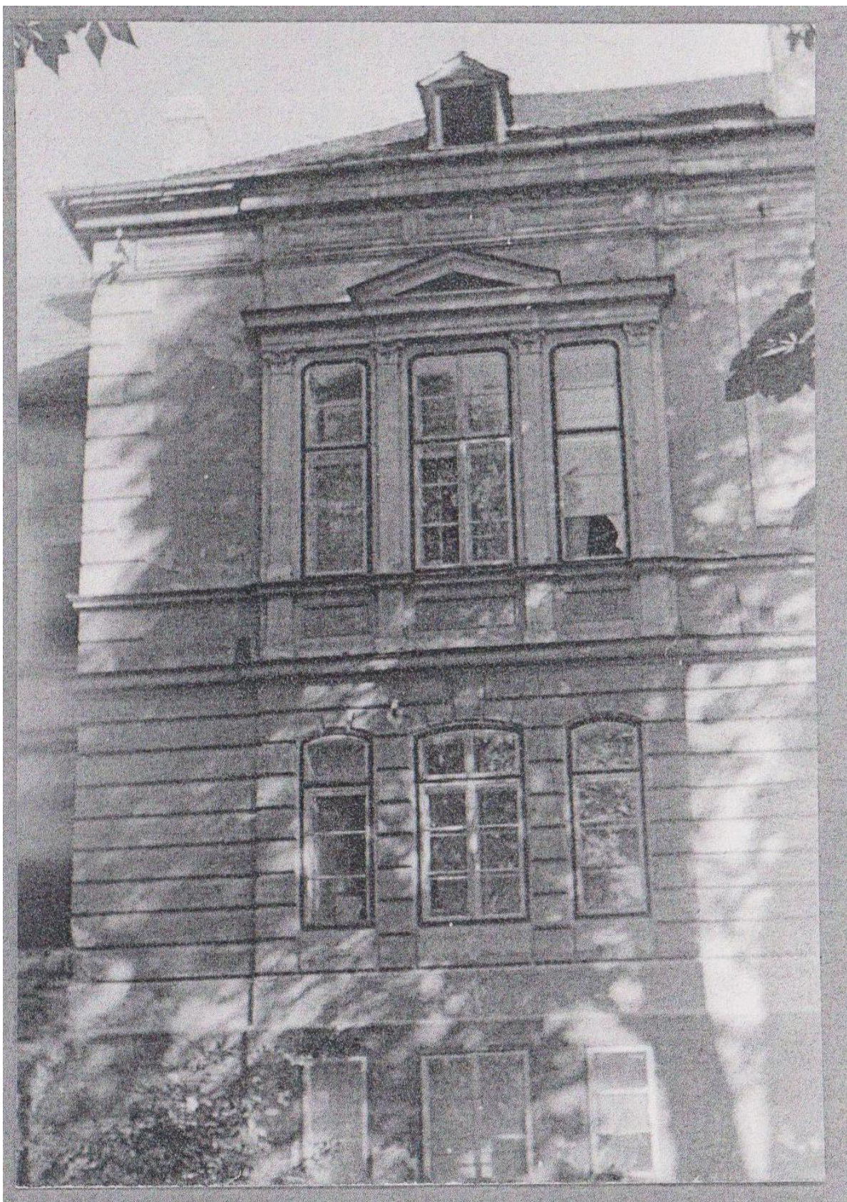
Výrazná jižní stěna s trojicí oken, které byly pozměněny rekonstrukcí v 70 letech minulého století.
